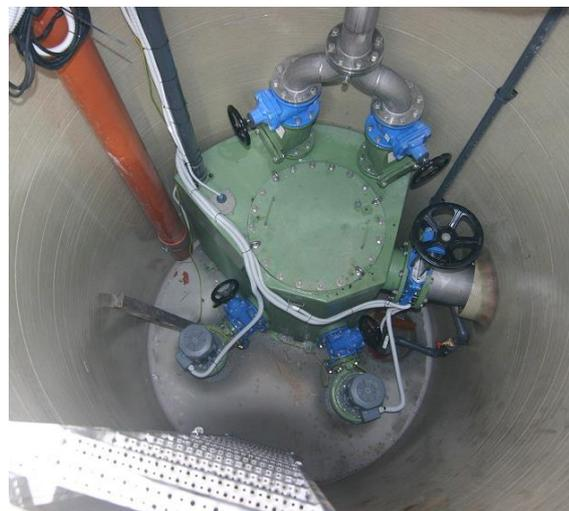
**Slika 5:** Maže-Novalja: AWALIFT 1/2 penta u oknu od staklom-ojačane plastike – AWAguard® premaz
